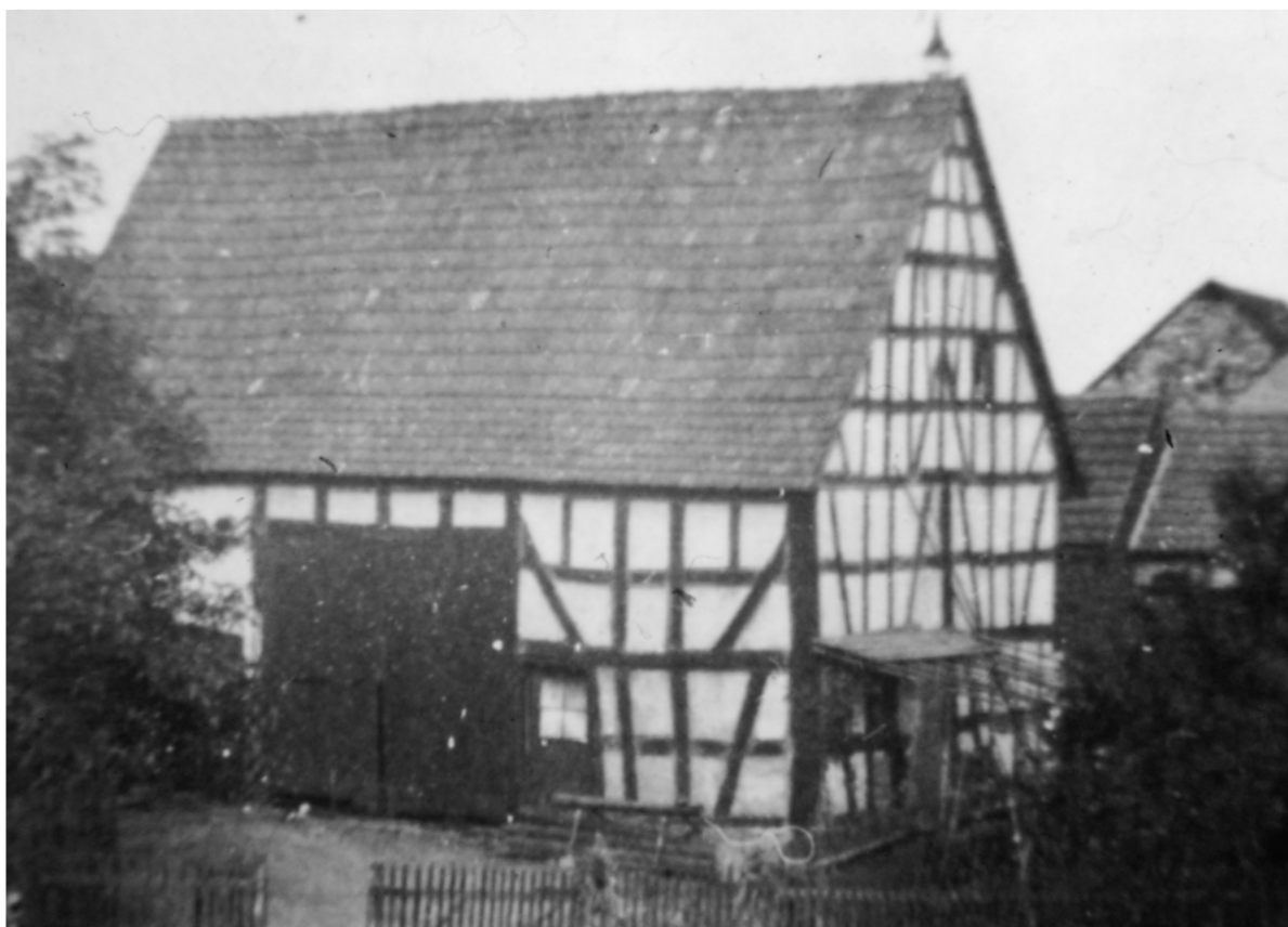
Scheune von Balthasar Wolf, heute Neubau Weingarten, Baumbacher Str. 12 (BK66)
